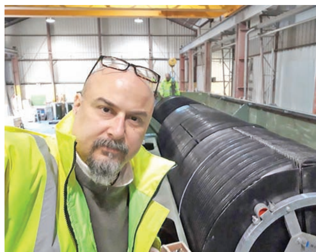
Рами Крестести е ВиК инженер, тук инспектира пакетна пречиствателна станция за отпадечни води, която използва RBC технология
